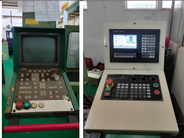
Gambar 2. Kondisi controller sebelum (kiri) dan sesudah (kanan) dilakukan retrofit
